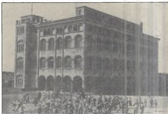
Parte construída: lados norte e nascente
