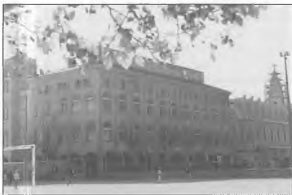
Oficinas de S. José: lado norte
