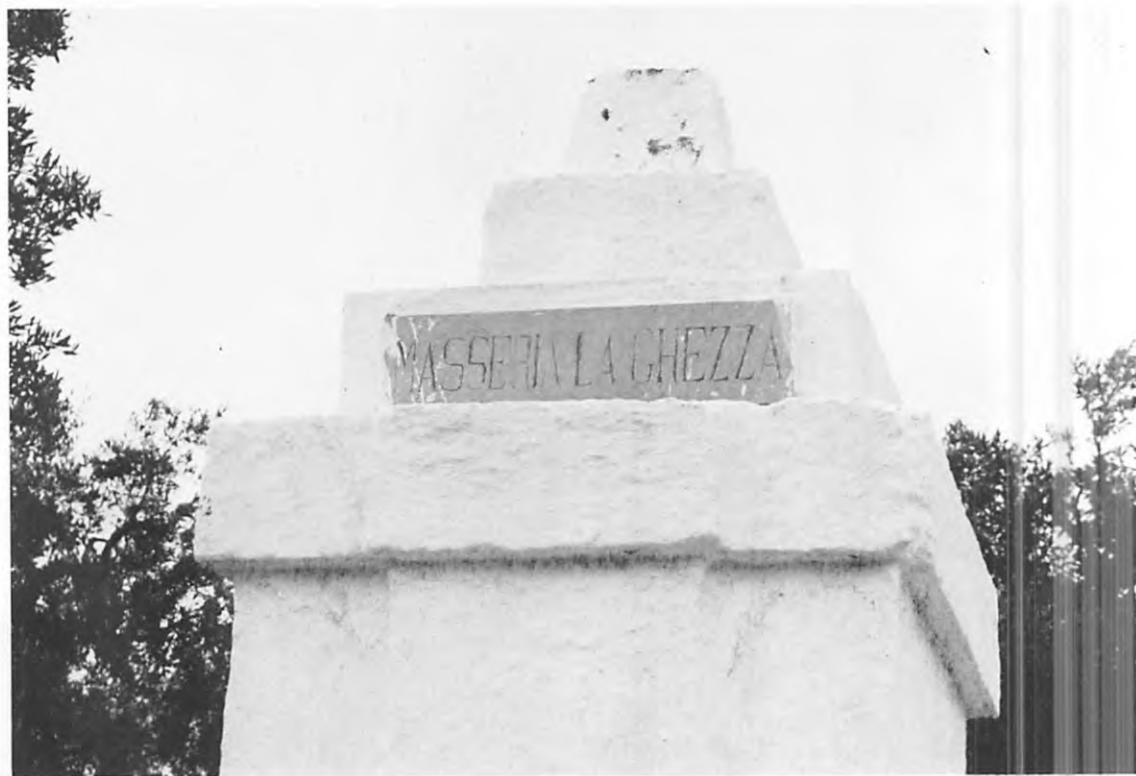
Particolare di una colonna della masseria La Ghezza. (Foto Zissner)
