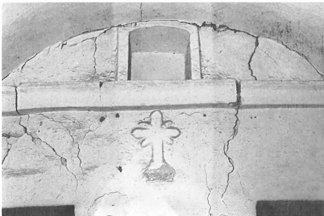
Particolare dell'interno: nicchia e croce in bassorilievo. (Foto Calabretto)
