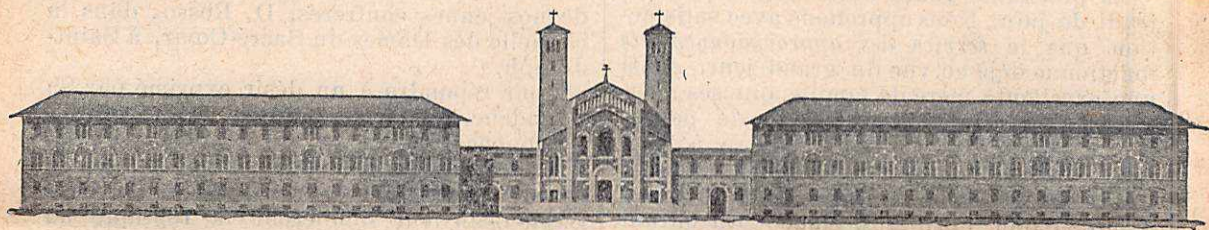
Partie déjà construite
