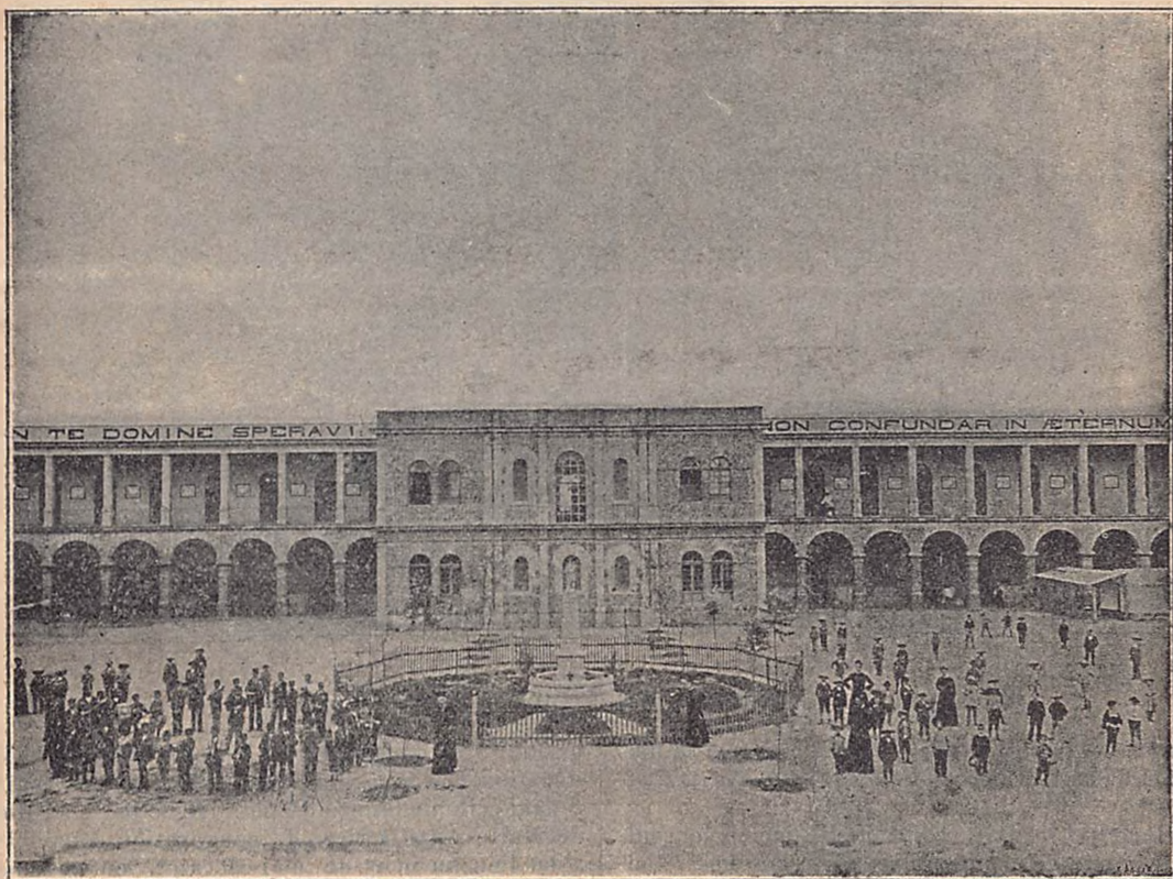
Vue intérieure de l'Oratoire salésien de Mexico
