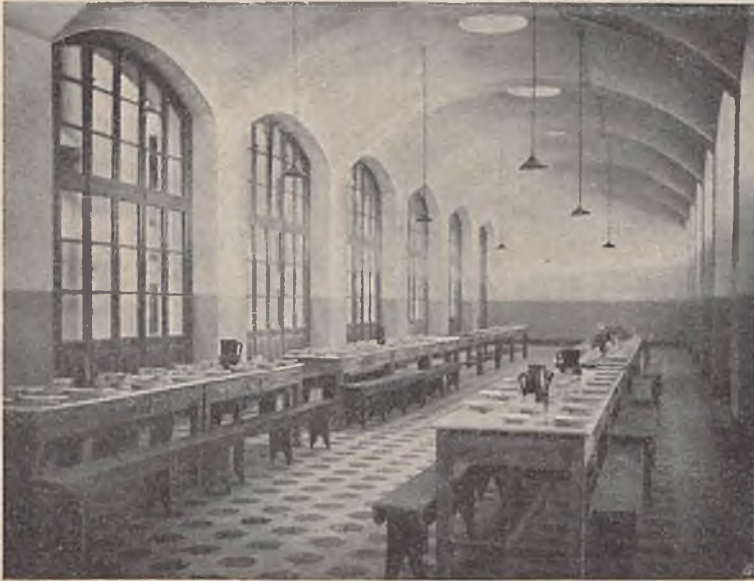
Un des réfectoires de la nouvelle maison de Lisbonne.
