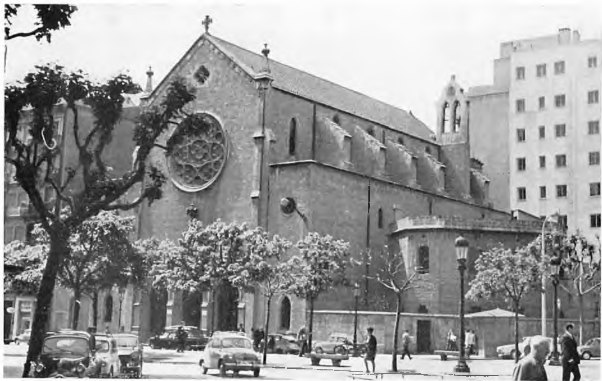
Iglesia Parroquial de San Raimundo de Peñafort. Perteneció al Convento de Nuestra Señora de los Angeles (Dominicas) y se hallaba en la que hoy es Avenida de la Puerta del Angel, siendo trasladada piedra por piedra a su actual emplazamiento en la Rambla de Cataluña, y reconstruida por el arquitecto Juan Martorell, a finales del pasado siglo.
