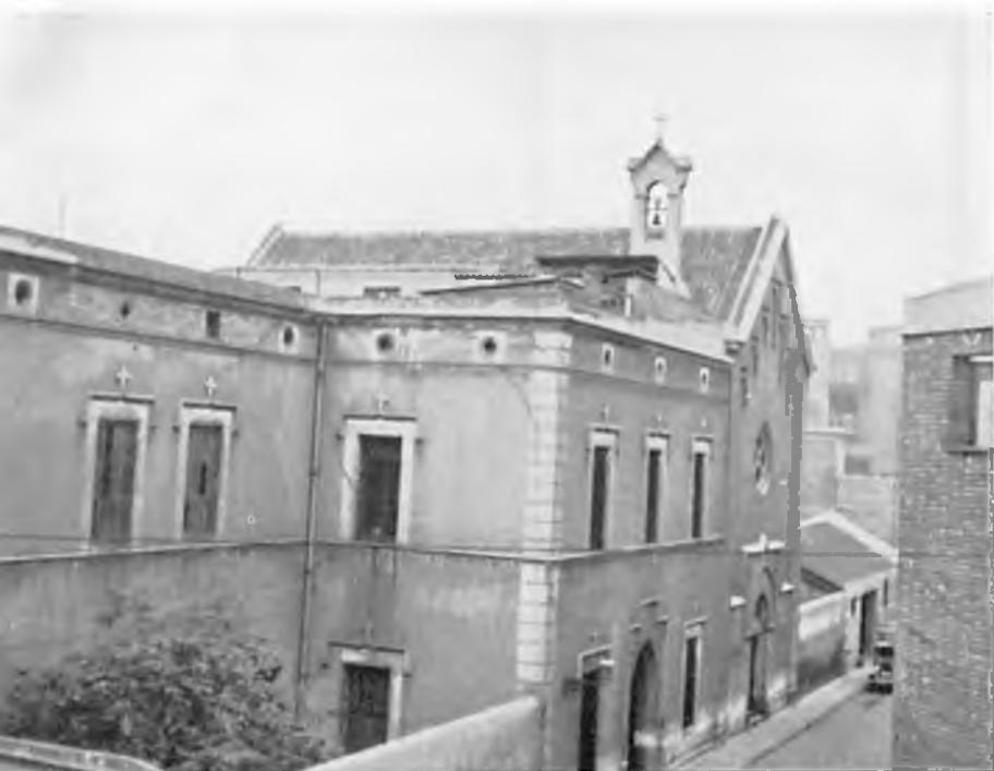
Asilo de S. Juan Bautista (Barceloneta): fachada.
